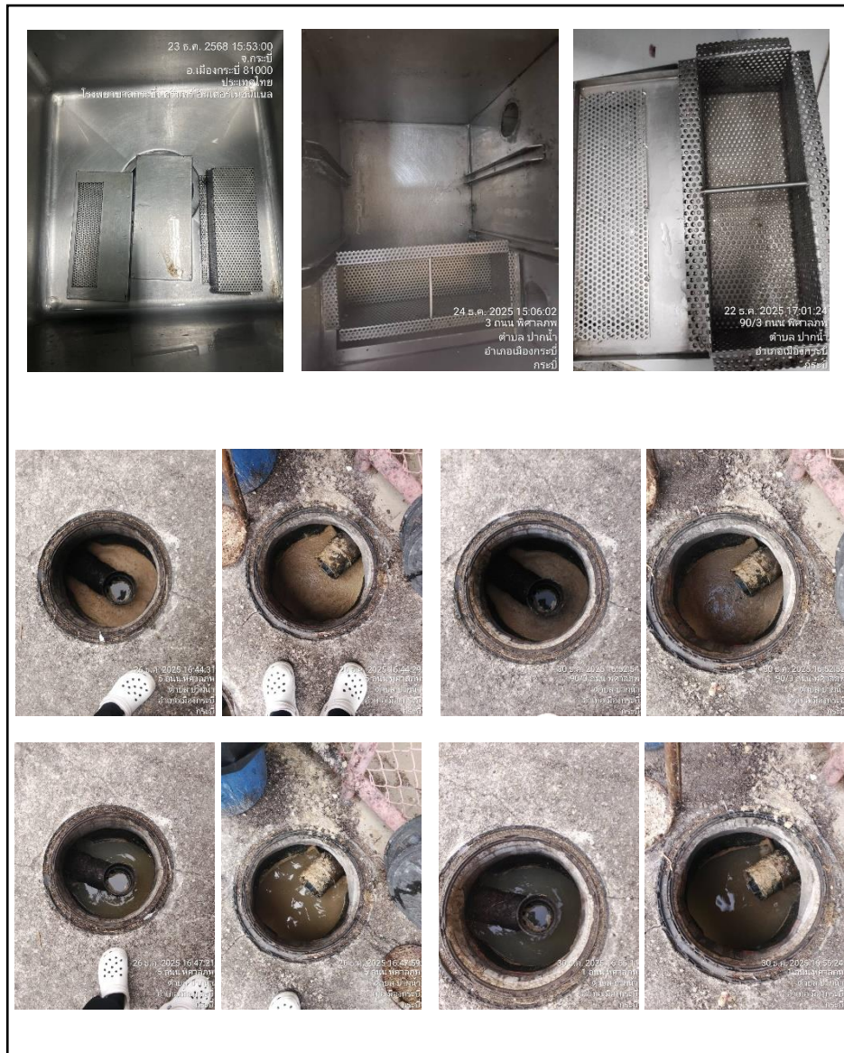
รูปที่ 3-14 การตักไขมันออกจากถังดักไขมัน
